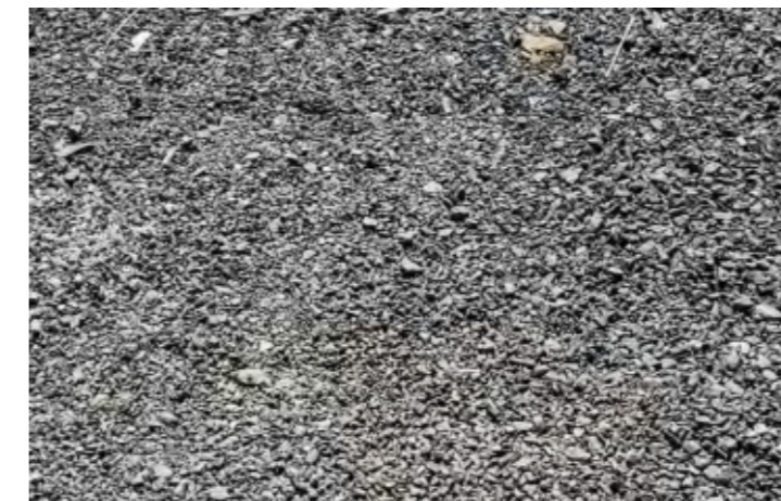
Photographie 124 : Texture des pistes en concassé granit.
