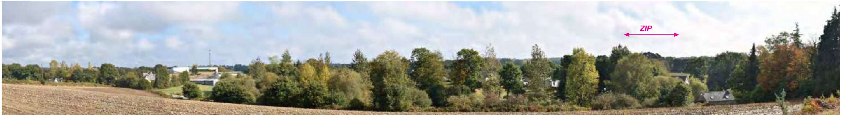
Photographie 47 : Visibilité sur le haut de la ZIP depuis la rue de Bourg la Reine à la sortie nord-est de Corlay.
