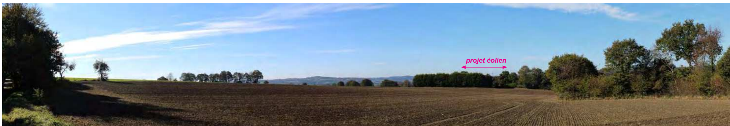
Photographie 139 : Vue en direction du projet, apparaissant au gré des ouvertures dans la végétation au premier plan, depuis la lisière de la forêt de l'Hermitage (photomontage 6).
