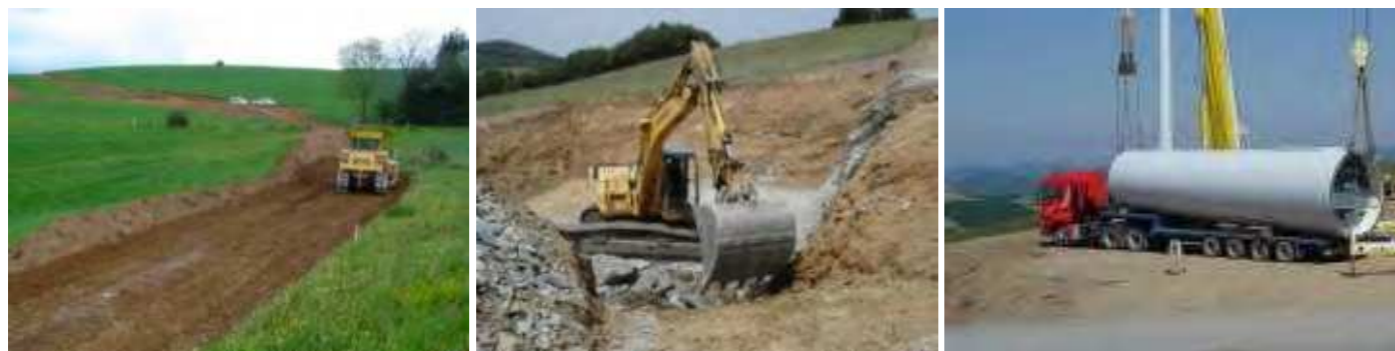
Photographie 131 : Illustration d'un chantier éolien
