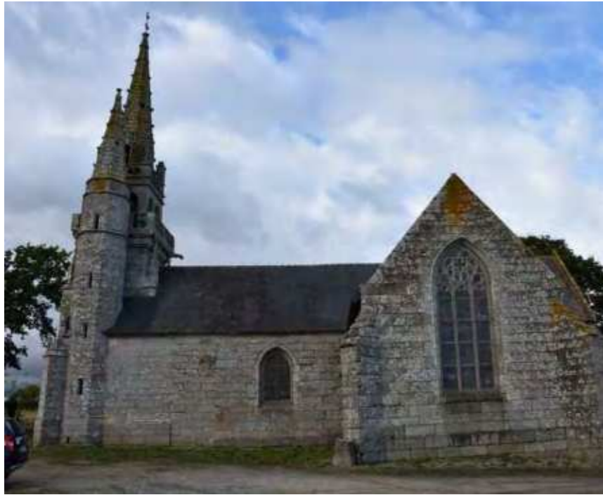
Photographie 31 : Chapelle Saint-Eloi (MH n°102)
